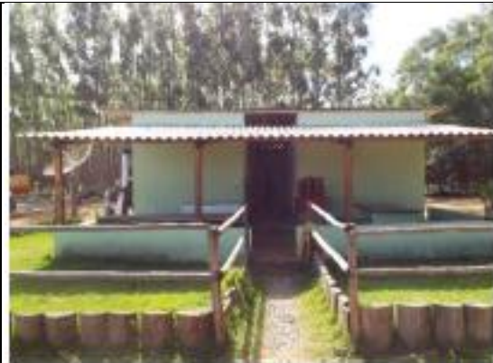
Foto 23: Refeitório com fossa séptica - 23 K 582585.00 m E; 8072970.00 m S
