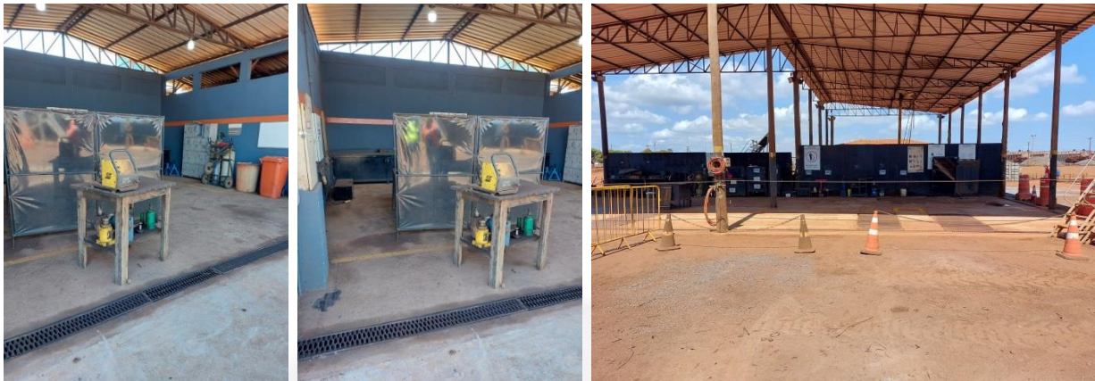
Fotos 12, 13, e 14 – Oficina mecânica instalada na UPE Forquilha.
