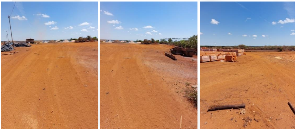
Fotos 19, 20 e 21 – Local proposto para ampliação – construção dos novos fornos.
