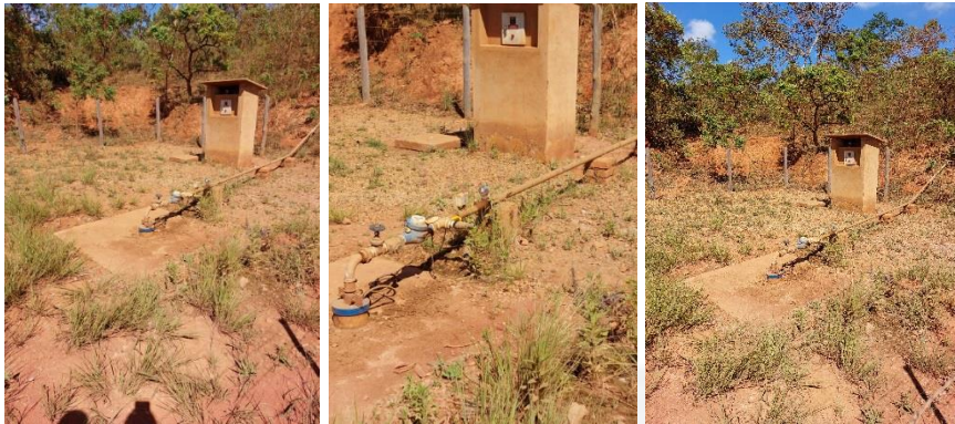
Fotos 1, 2 e 3 – Ponto de captação hídrica subterrânea, que abastece a UPE Forquilha.
