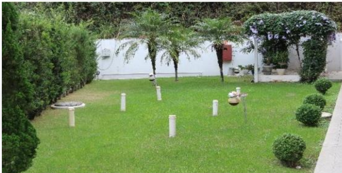
Foto 13: Tratamento dos efluentes sanitários - fossas septicas/filtros anaeróbios
