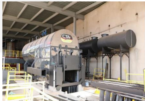
Foto 4: Nova caldeira movida a lenha, pelos, cerdas, cascos, etc.
