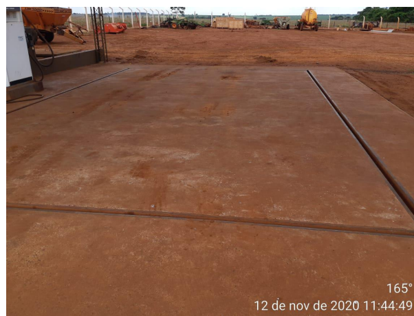
Figura 12. Pista de abastecimento de combustível
