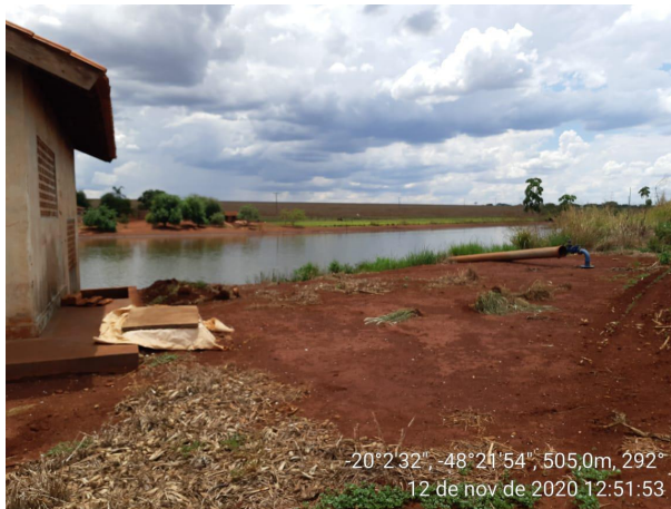
Figura 5. Captação de água superficial
