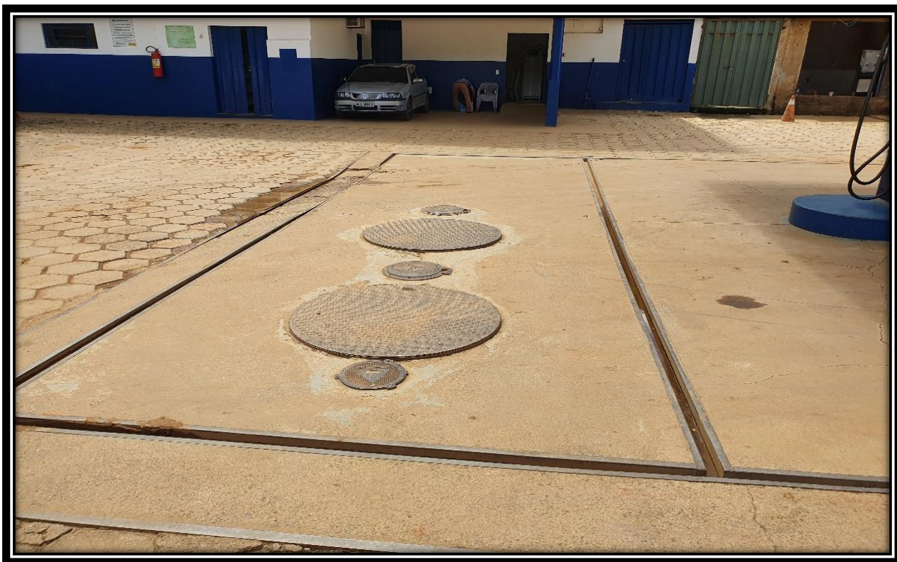
Figura 4: Sistema de drenagem composta por canaletas perimetrais na pista de abastecimento.
