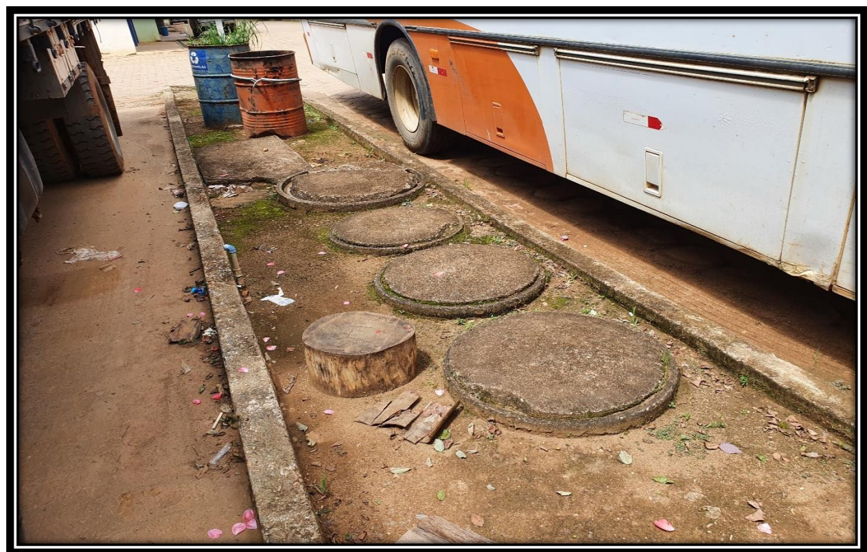
Figura 5: Sistema de tratamento de efluentes composta por caixa SAO.
