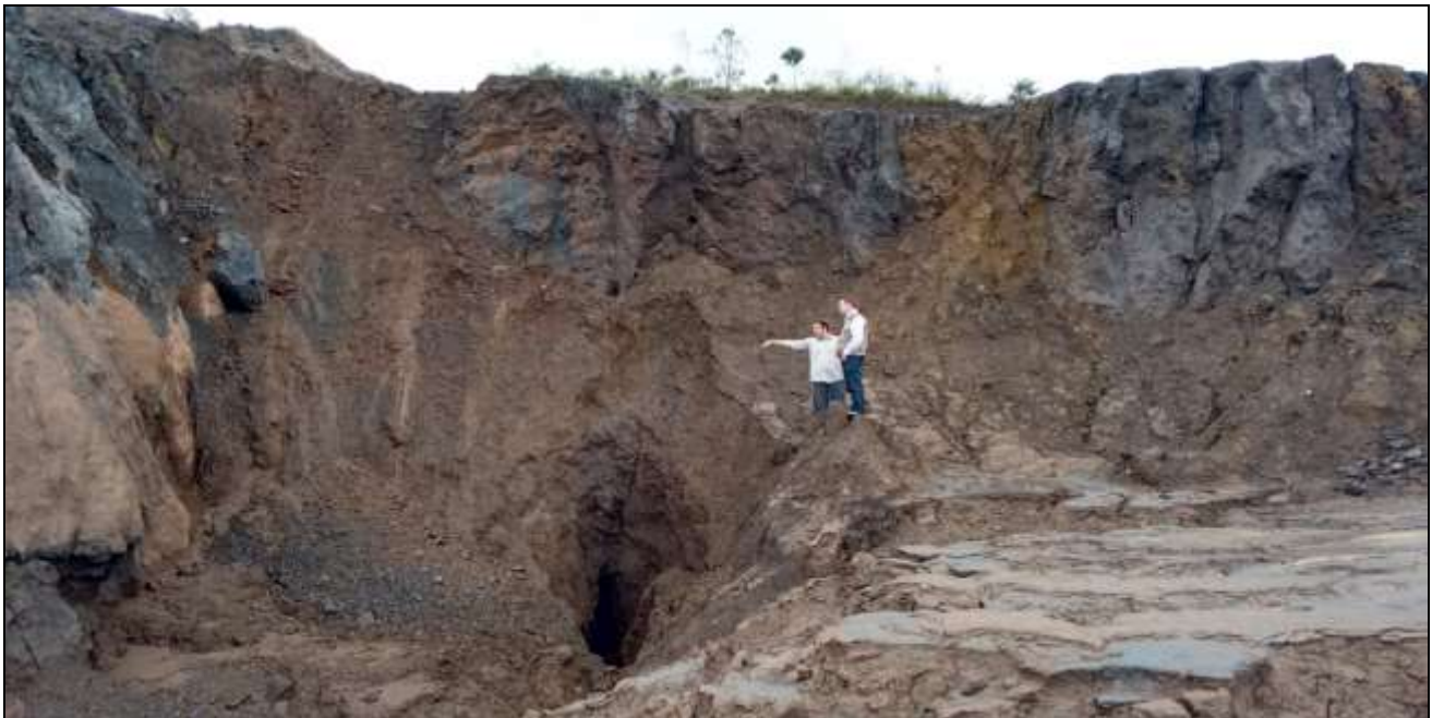
Figura 10 Entrada da caverna localizada na porção a montante da Barragem B4, no local onde se formou o vórtex (Fonte: SUPRAM CM).
