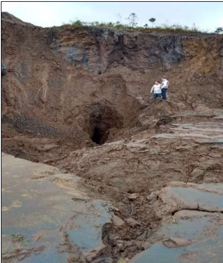
Figura 11. Entrada da cavidade natural subterrânea localizada no interior da Barragem B4 (Fonte: SUPRAM CM).
