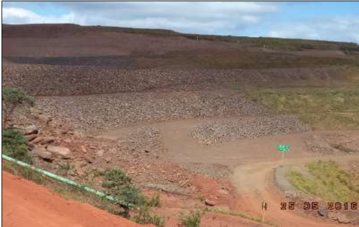
Foto 2: Reconstrução dos taludes e bermas
