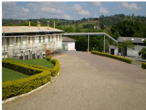
Foto 06. Vista parcial da empresa
