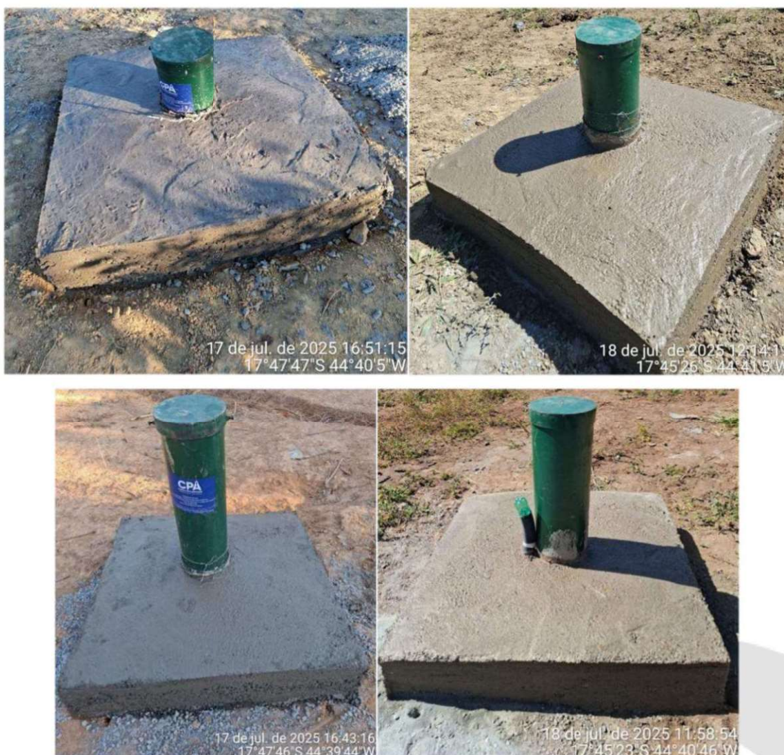
Figura 2: Evidências dos poços com as lajes sanitárias instaladas
