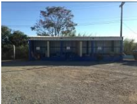
Foto 01. Depósito temporário de resíduos sólidos.
