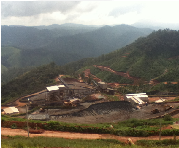
Foto 03. Vista geral da UTM.
