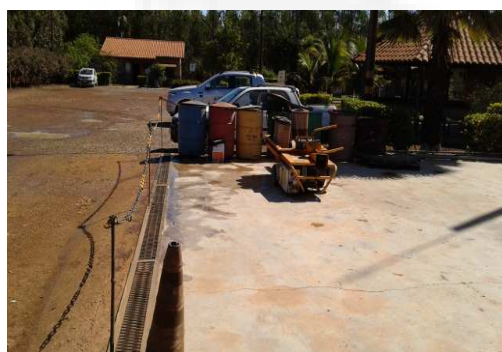
Figura 03. Piso impermeabilizado da oficina
