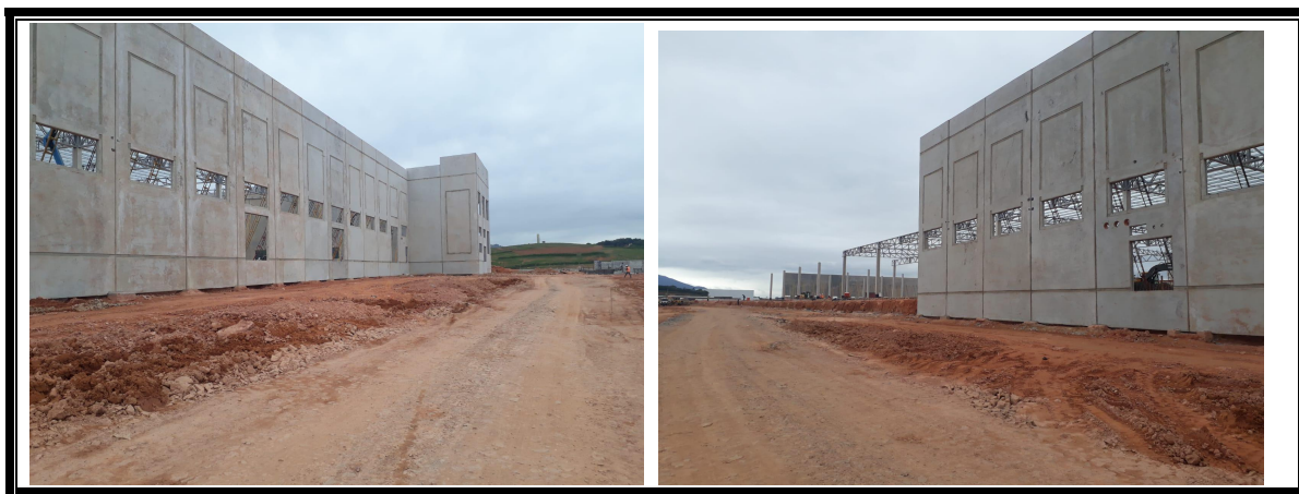
Figura 04: Fotos de parte dos galpões em construção.
