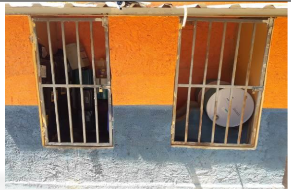
Foto 08: Armazenamento de materiais
