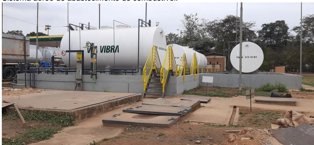
Figura 04 – Sistema aéreo de abastecimento de combustível.
