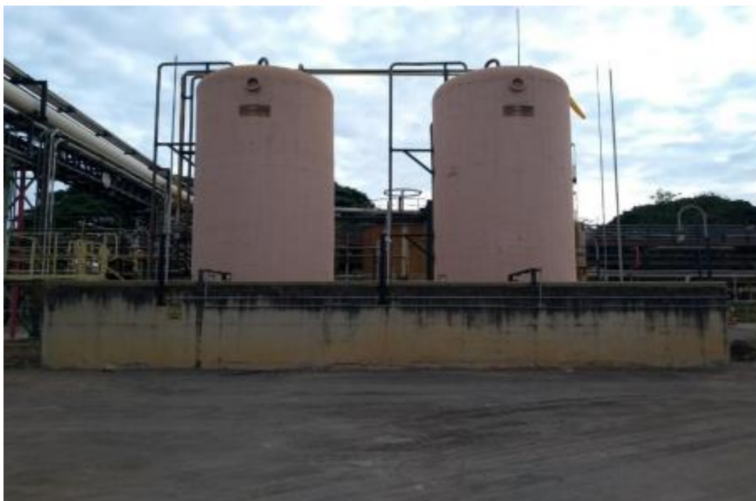
Figura 12. Área de armazenamento de cloreto de sódio – solução de salmoura.
