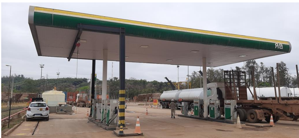
Figura 04 – Sistema aéreo de abastecimento de combustível.
