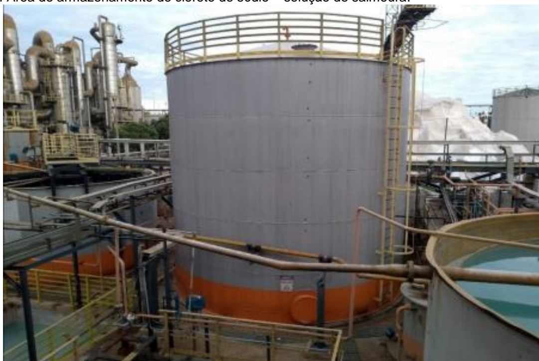
Figura 12. Área de armazenamento de cloreto de sódio – solução de salmoura.
