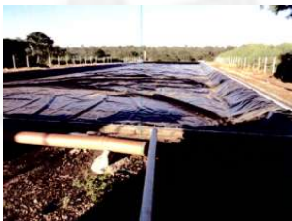
Foto 11. Biodigestor após manutenção.
