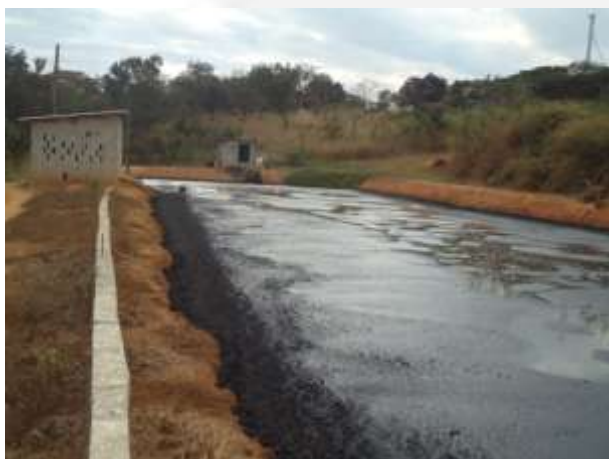
Foto 12. Antiga lagoa após o biodigestor.
