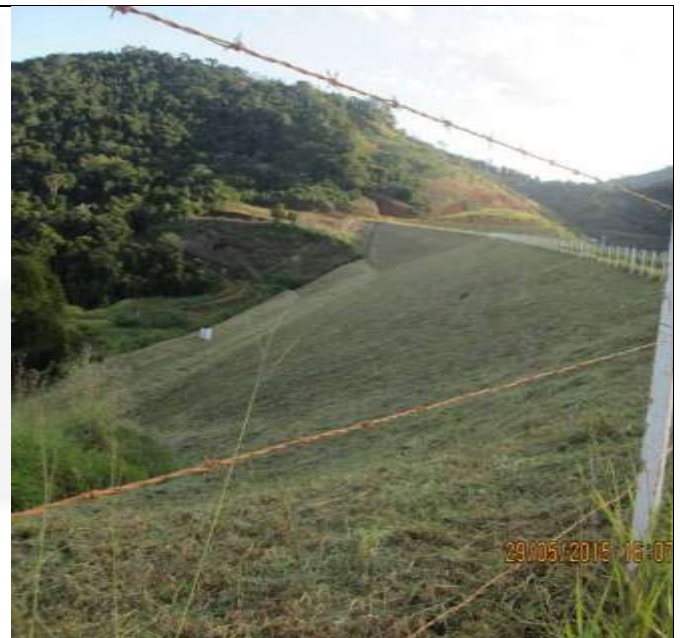
Foto 22: barramento da barragem de rejeito
