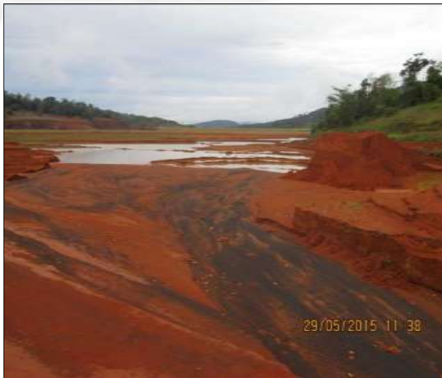
Foto 7: vista parcial da barragem de rejeitos
