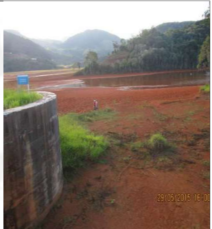
Foto 20: barragem de rejeito e o seu vertedouro
