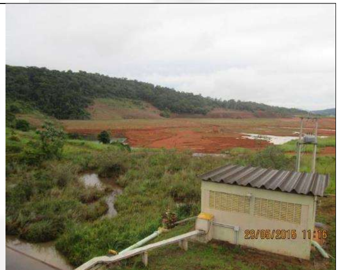
Foto 6: vista geral da barragem de rejeitos no ribeirão São Lourenço
