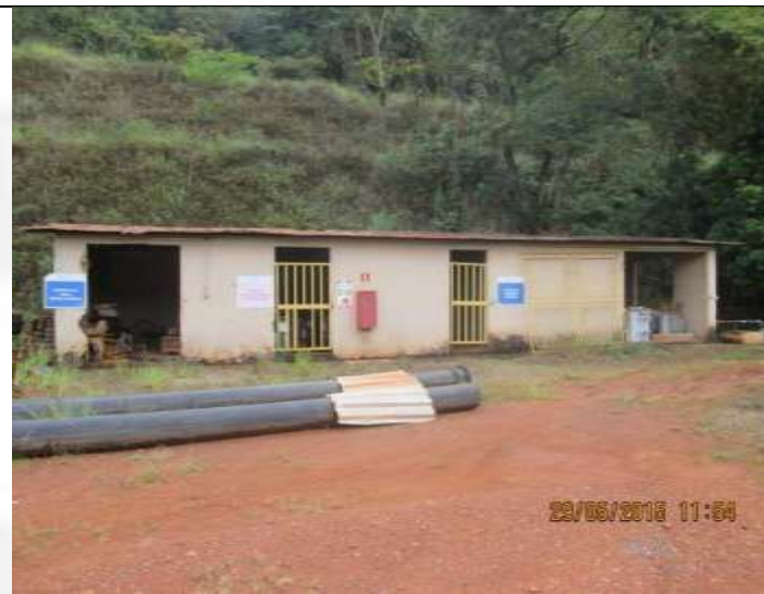
Foto 8: depósito de materiais elétricos, peças novas e usadas, resíduos sólidos e líquidos contaminados
