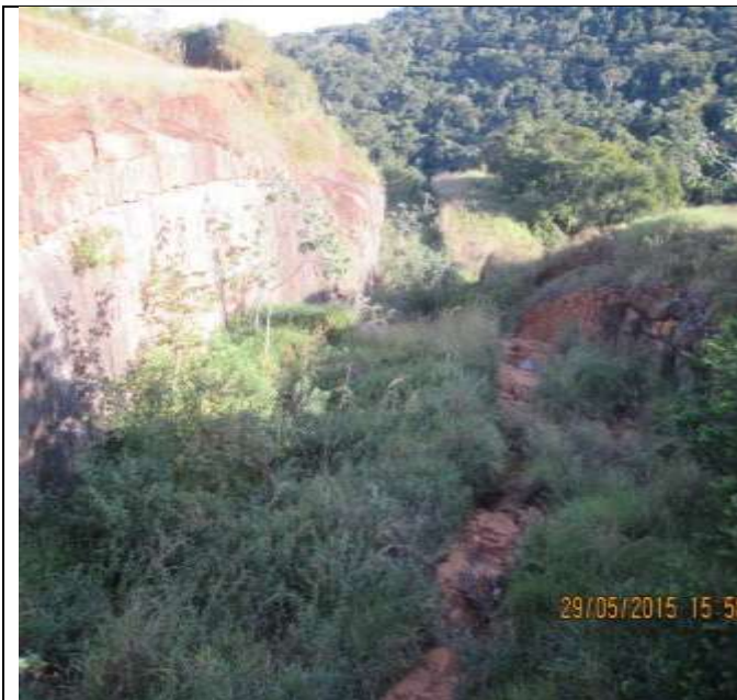
Foto 21: vista a jusante do vertedouro da barragem de rejeitos
