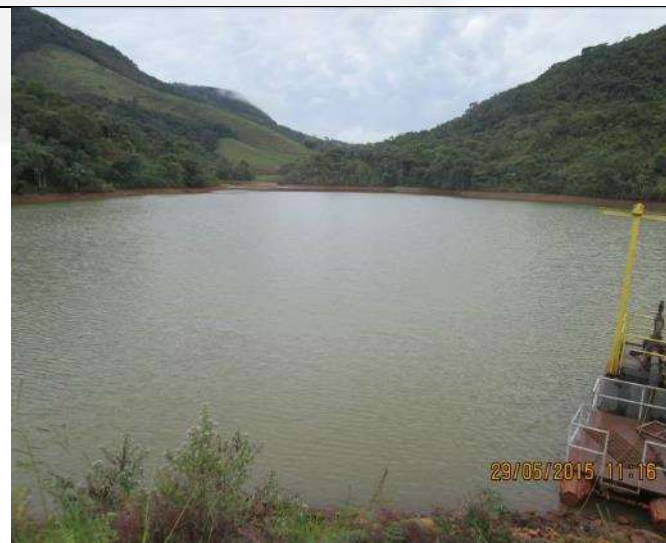
Foto 5: vista geral da barragem de água nova que alimenta a UTM
