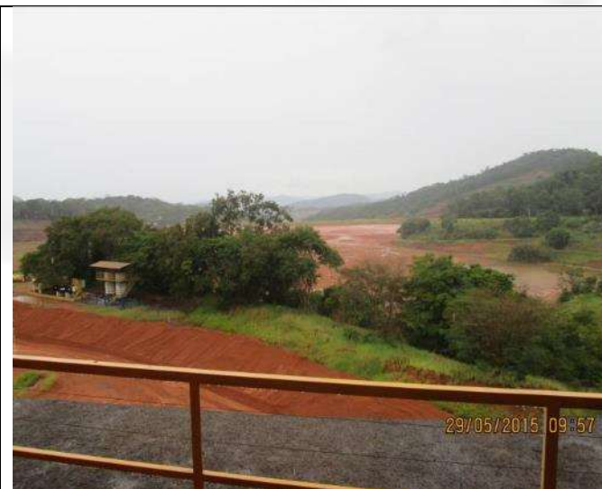
Foto 1: vista parcial da barragem de rejeito e do sistema de tratamento de efluente sanitário
