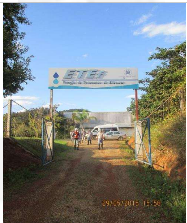
Foto 18: estação de tratamento de efluentes da barragem de rejeito
