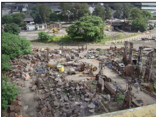
Foto 03. Pátio de Sucatas que será relocado para construção do Alto-Forno 4.
