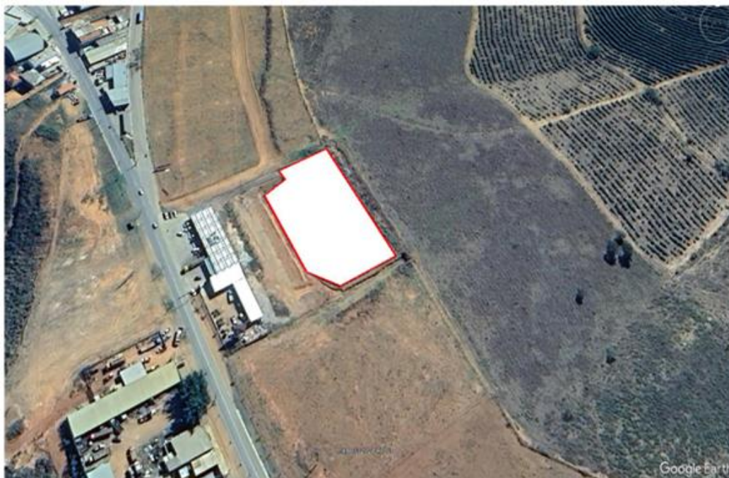
FIGURA 21 - IMAGEM AÉREA DA POLIGONAL 3 DO CANTEIRO DE OBRAS “CAPELINHA”
