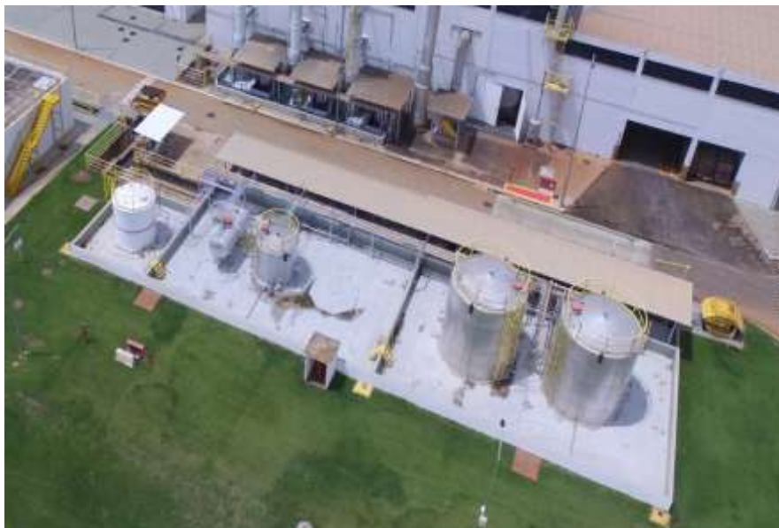
Foto 3 - Armazenamento de combustíveis e soda cáustica. - Fonte: RADA
