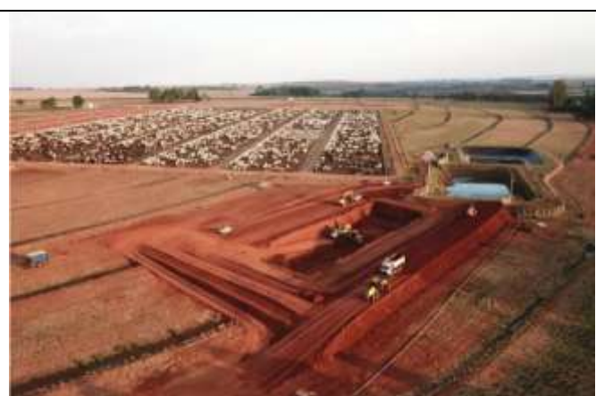
Figura 4 - Reservatórios de efluentes (novo)
