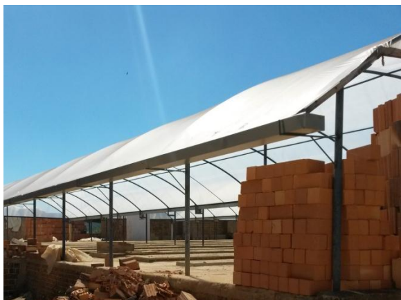
Foto 11: Sistema de drenagem pluvial.
