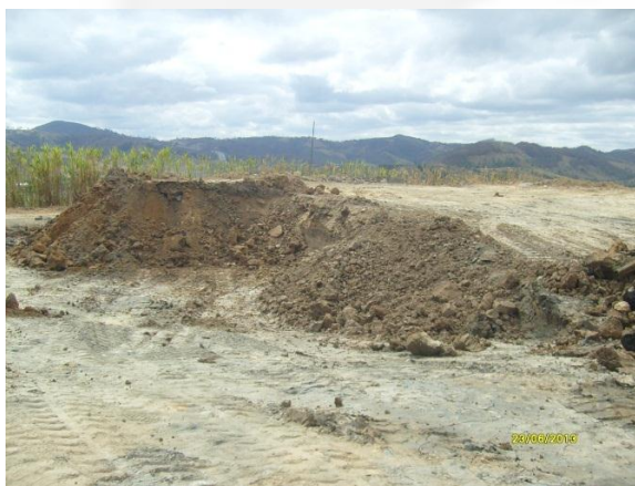
Foto 1: Depósito de argila.
