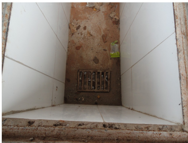
Imagem 05: Pista de troca de óleo.
