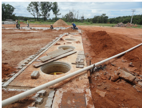
Imagem 02: Instalação dos tanques
