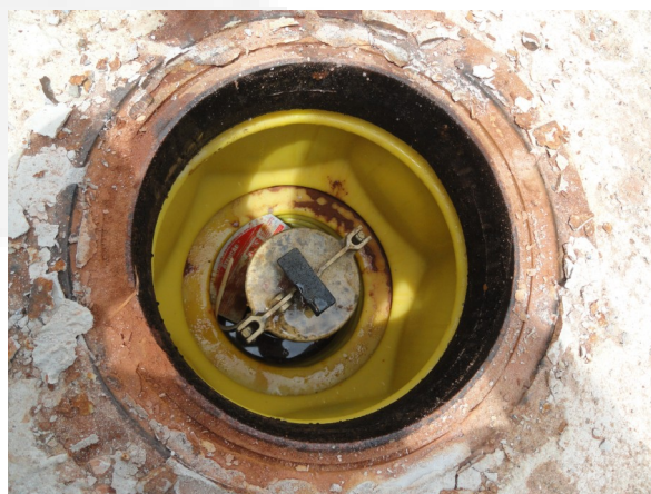
Imagem 04: Pontos de descarga do SASC.
