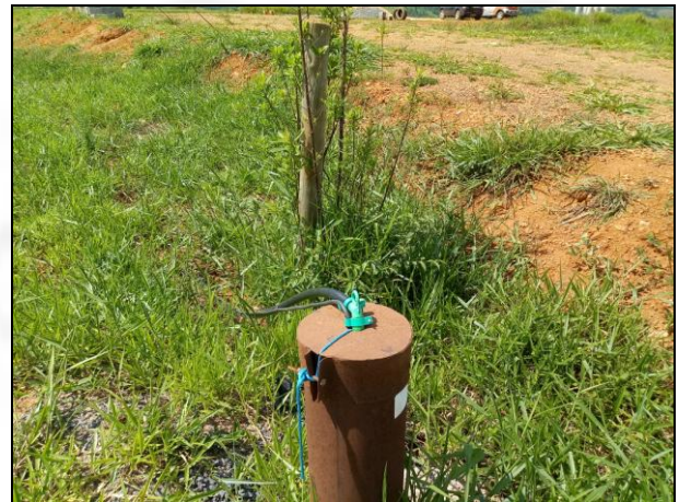
Figura 2: Captação de água subterrânea.
