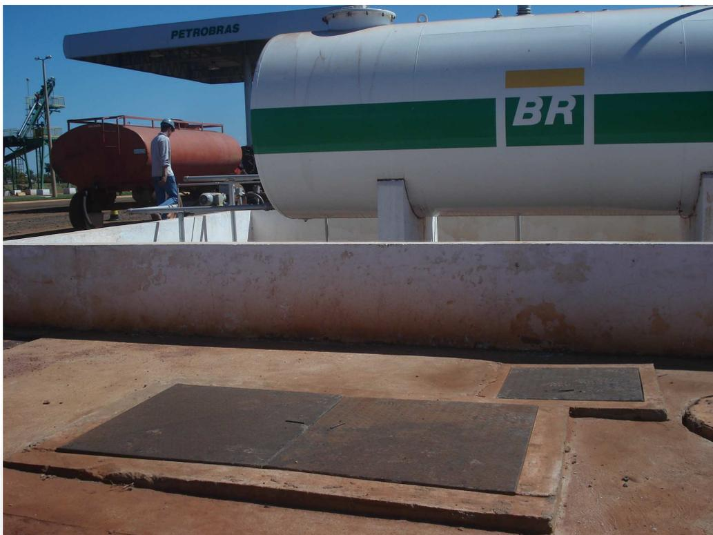
Foto 02: Área do posto, tanques dotados de bacia de contenção, sistema de drenagem oleosa interligada à caixa S.A.O., entre os demais equipamentos, câmaras de contenção presentes (‘‘sump e sill container’’).
