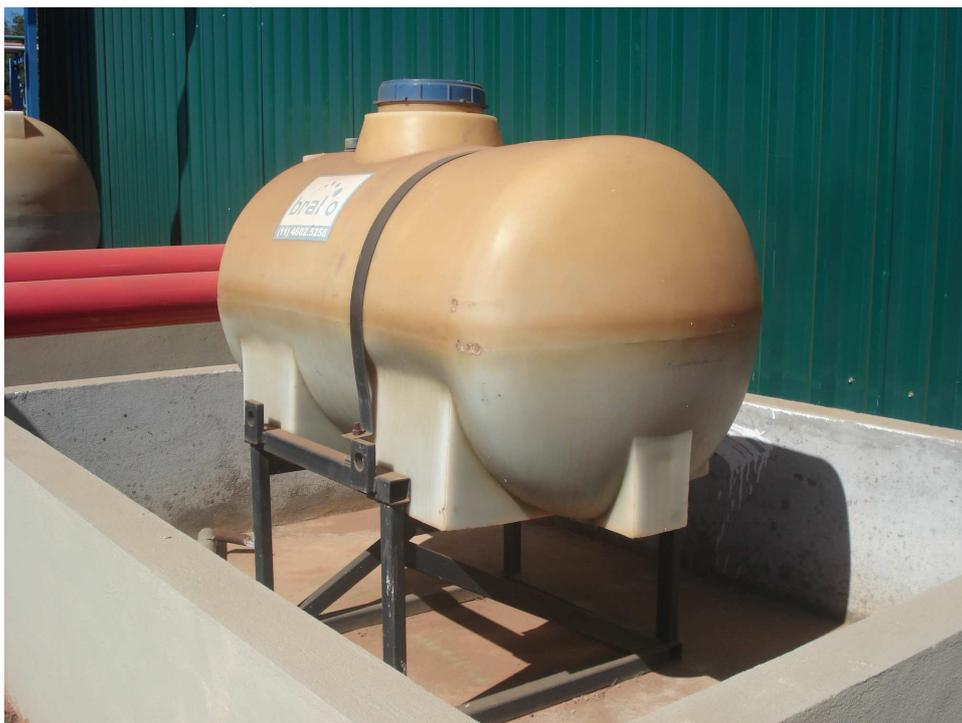
Foto 03: Tanque de diesel junto ao equipamento de combate a incêndios, agora dotado de bacia de contenção, interligação à" caixa S.A.O".
