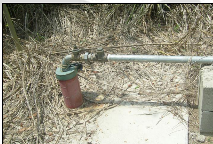
Foto 02: Representação do poço 1 para exploração de água subterrânea requerido pelo processo de outorga nº 11026/2015, nota-se a existência de laje de proteção sanitária e sem horímetro.
