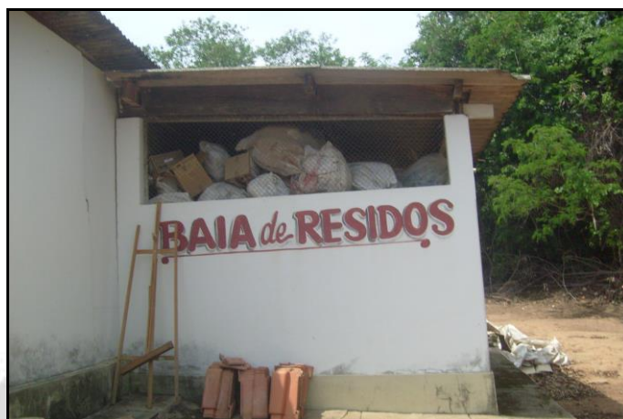
Foto 12: Local de armazenamento temporário dos resíduos sólidos.
