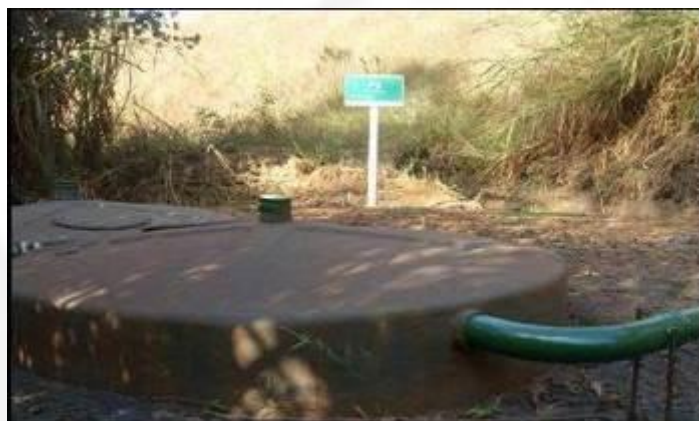
Figura 14 Sistemas separadores de óleos e água nas oficinas de manutenção de máquinas e veículos, utilizando-se de separadores físicos
