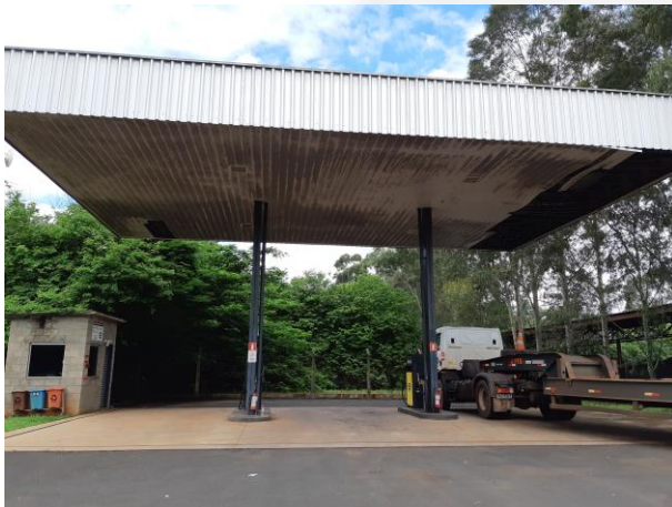
Foto 01. Posto de abastecimento
