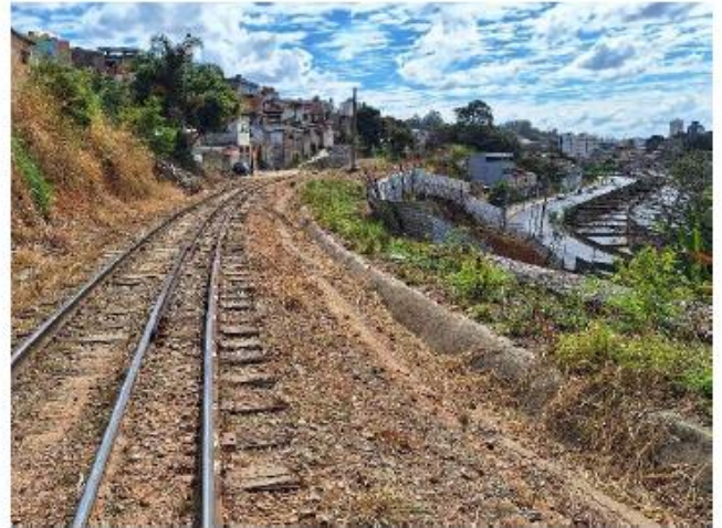
Figura 04 - Trechos em que os taludes e encostas adjacentes à linha férrea estão com sinais de instabilidade. Fonte: RCA – METRÔ BH, 2024.
