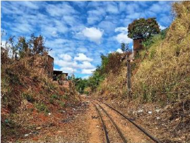
Figura 04 - Trechos em que os taludes e encostas adjacentes à linha férrea estão com sinais de instabilidade. Fonte: RCA – METRÔ BH, 2024.
