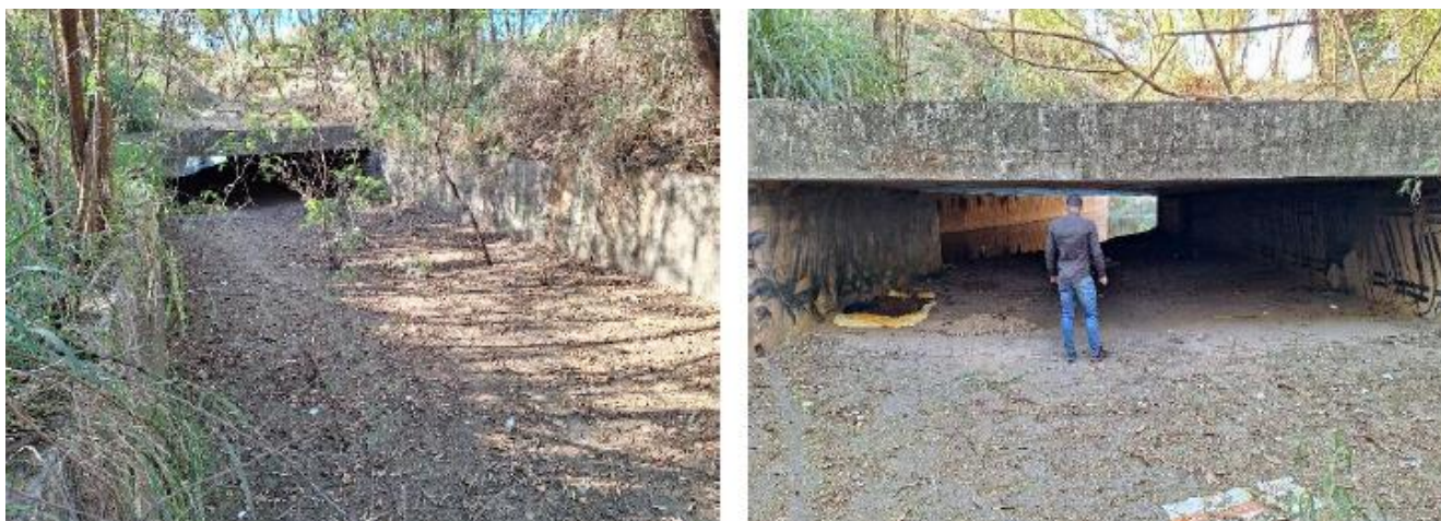
Figura 06 – Vista geral e próximo do canal de extravasamento de cheias. Fonte: RC - METRÔ BH.2024.
