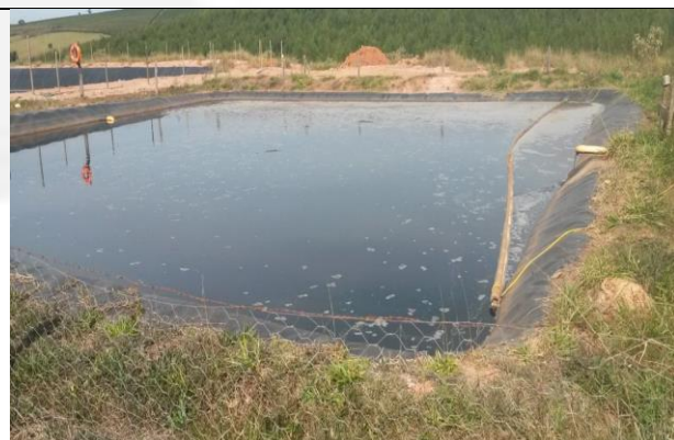
Lagoa anaeróbia da ETE
