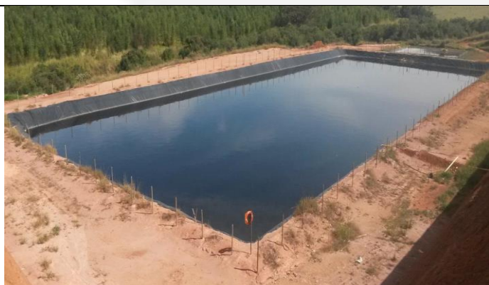
Lagoa facultativa da ETE
