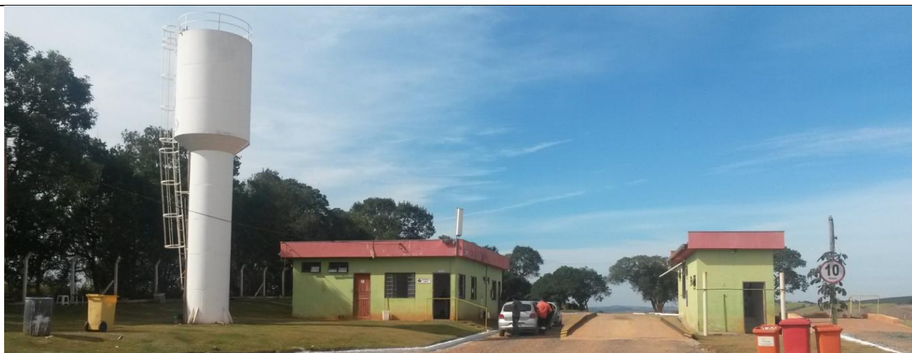
Vista geral: caixa d'água metálica, prédio administrativo, prédio de controle de resíduos e as 02 balanças rodoviárias
