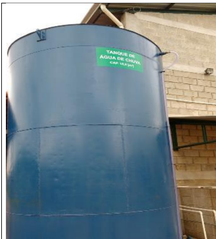
Tanque de água de chuva
