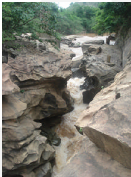
Foto 2. Local de intervenção.
