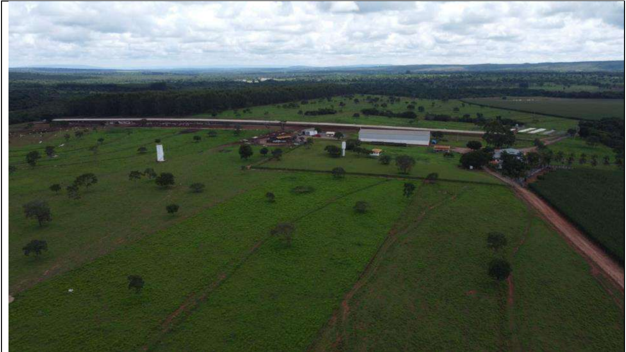
Vista do galpão parcialmente coberto e sede
