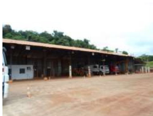
Foto 04: Canteiro de Obras
