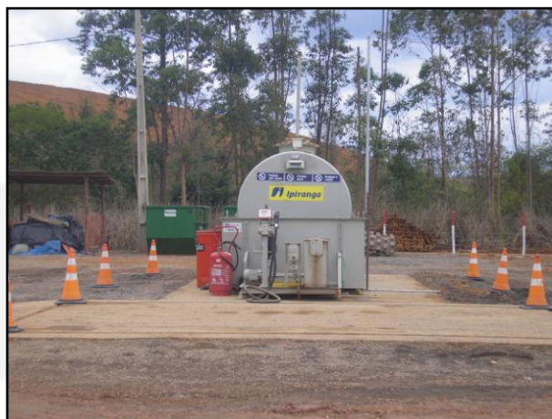
Foto 02: Ponto de abastecimento de combustível.
