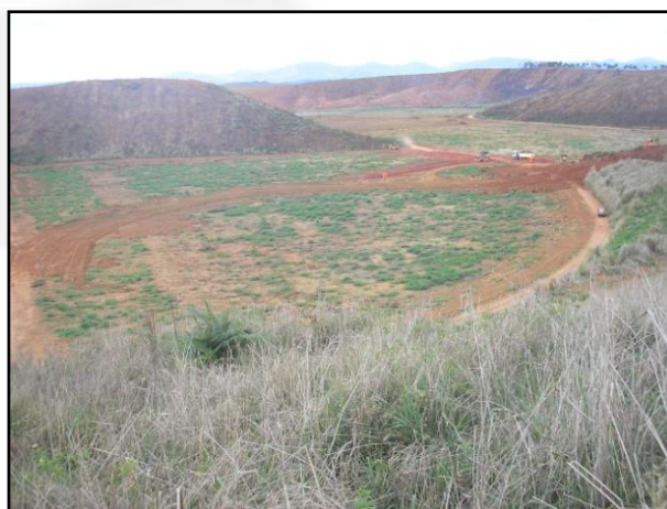
Foto 06: Vista geral da Gleba E.
