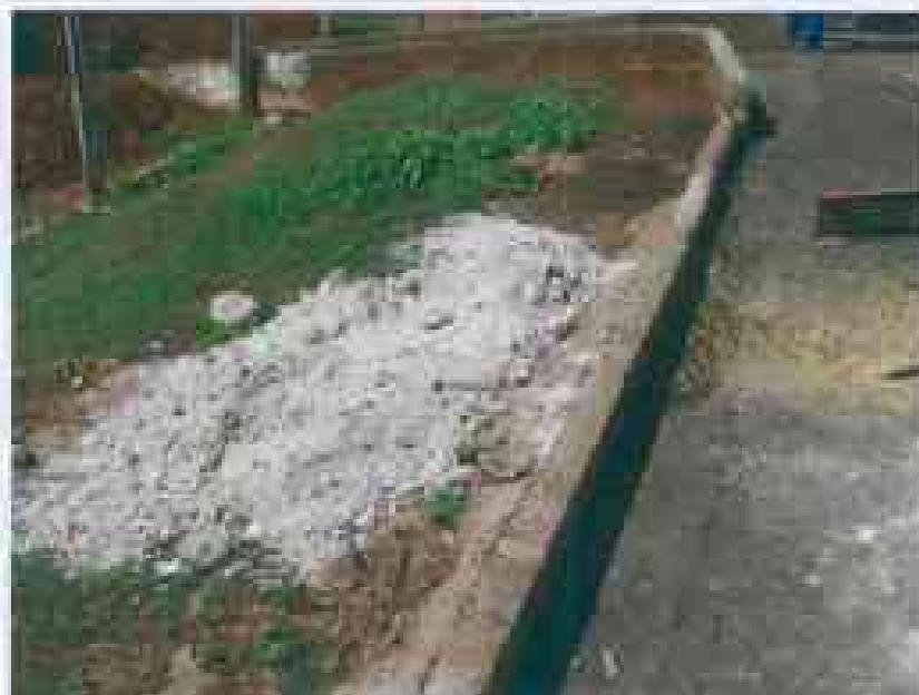
Figura 09 – Fotografia 03 – O intenso tráfego de caminhões e sua manutenção permite a perda de grãos e outros materiais que ficam depositados na pista do estacionamento e que podem ser carregados para as linhas de drenagem.
