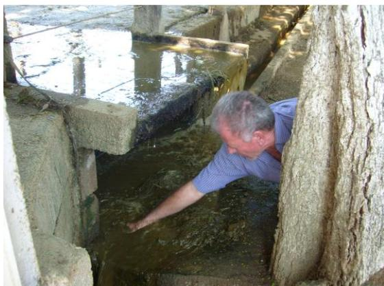
**Foto 11:** Pedra tampando a passagem do efluente da lavagem dos currais para a ETEI.
