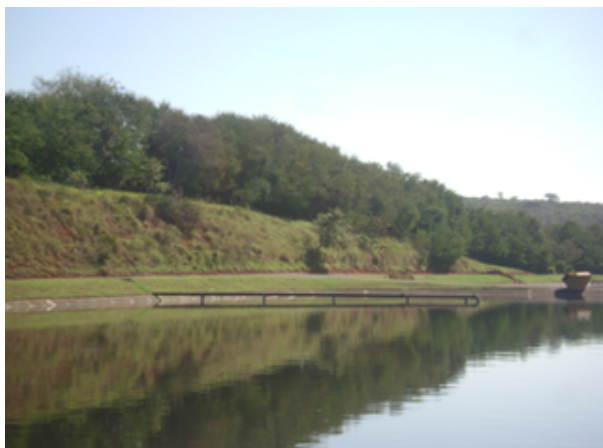
Foto 05. Cortina arbórea adensada e taludes Revegetados
