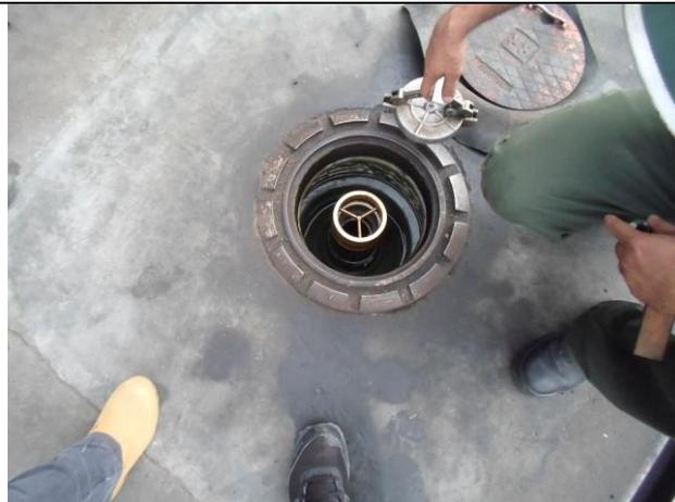
Foto 3: Anel de vedação na boca de descarga do tanque de armazenamento.
