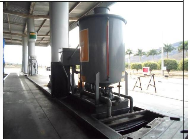
Foto 6: Unidade de filtragem de combustível na pista de abastecimento
