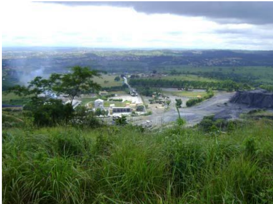
Imagem 01: Vista geral do empreendimento.
