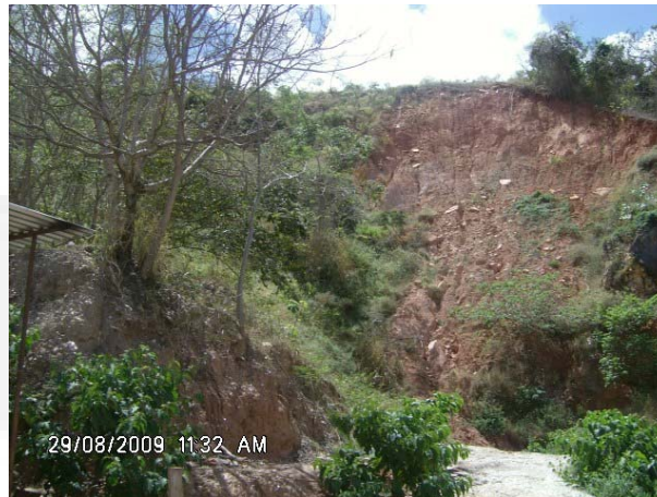
Foto 02. Área proposta para recuperação através do Plano de Controle de Processos Erosivos.
