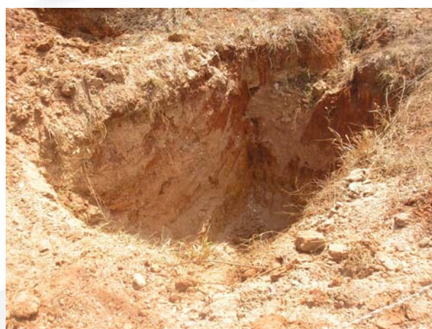
Foto 04. Sistema de canaletas de drenagem e caixas secas.
