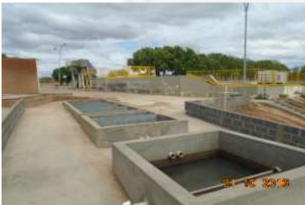
Foto 01. Decantador – lavagem de veículos
