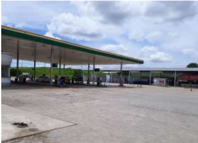
Foto 01: Vista geral do empreendimento.
