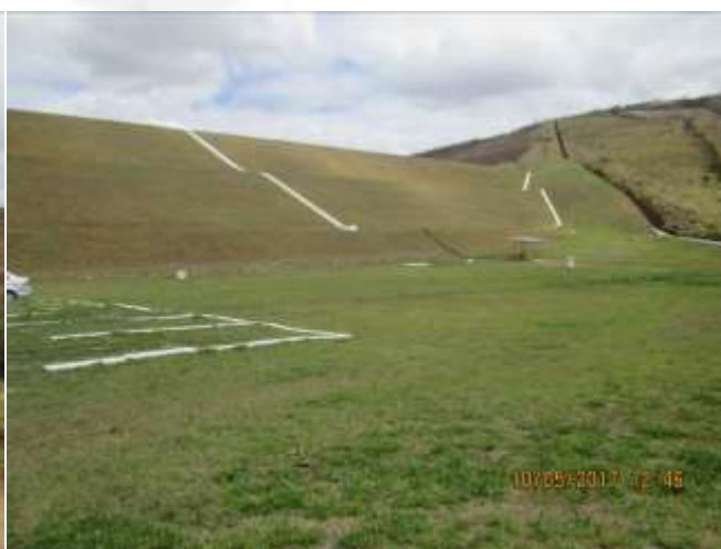
Figura 08: Crista da barragem.
