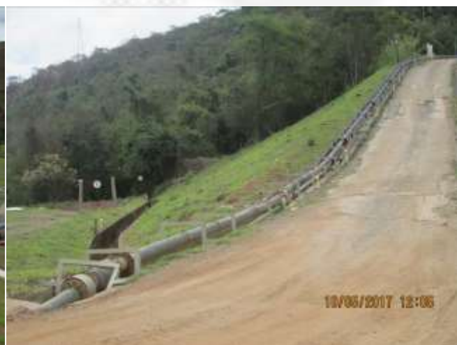
Figura 04: Tubulação de bombeamento de resíduos para a barragem.
