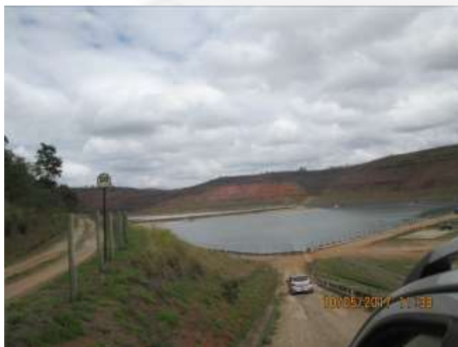
Figura 01: Vista geral da barragem.
