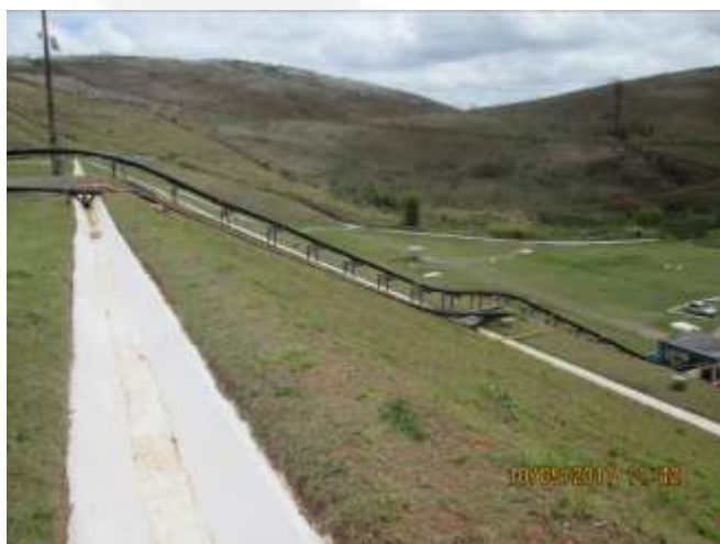
Figura 03: Tubulação de retorno da água sobrenadante.
