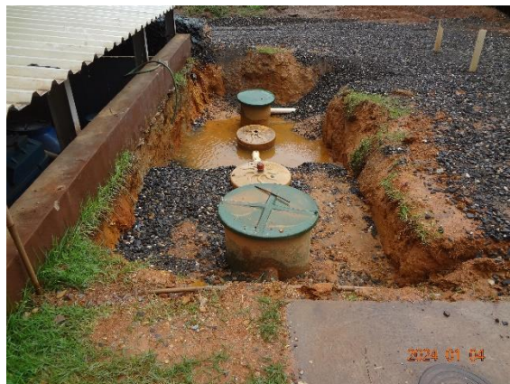
Foto 66 Biodigester associado aos banheiros da oficina mecânica.
