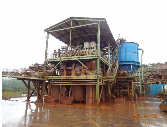
Foto 3 Unidade de Tratamento de Minério a Úmido por separação magnética
