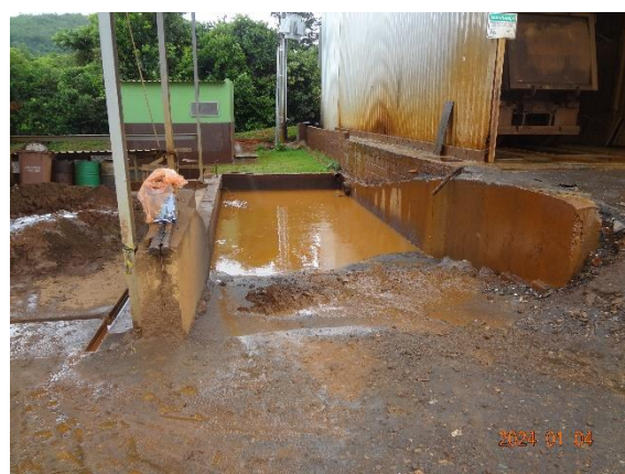
Foto 52 Bacia de sedimentação de efluente contaminado
