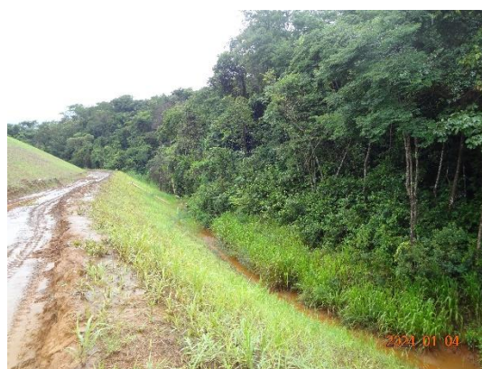
Foto 22 Canal de água ao longo da lateral sul/oeste/noroeste da pilha definitiva, vertendo para dentro dos Sumps principais.
