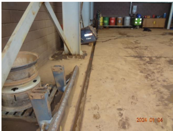
Foto 31 Canaletas no interior da oficina junto aos lavadores de carros e caminhões.
