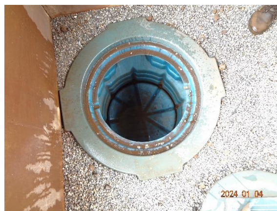
Foto 42 Recipiente de coleta de borra de óleo da CSAO da oficina da UTM a Seco
