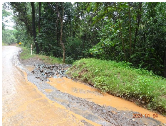
Foto 60 Estrutura de pedra construída para diminuir o carreamento de sedimento para o curso d'água e diminuir a velocidade do fluxo da enxurrada.
