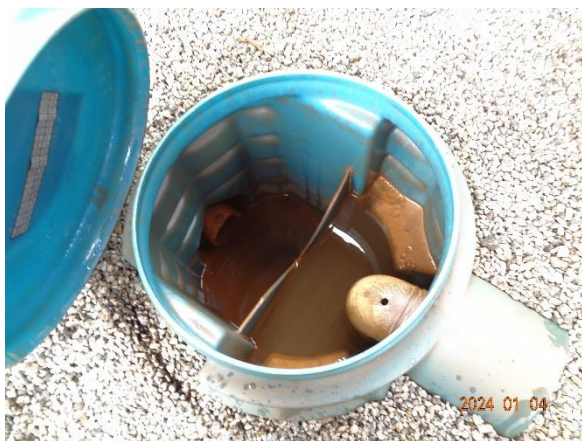
Foto 41 Recipiente que recebe o efluente da CSAO da oficina da UTM a Seco. O efluente é lançado em sumidouro.
