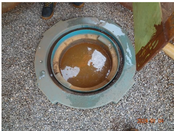
Foto 39 Entrada do contaminante na CSAO da oficina da UTM a Seco
