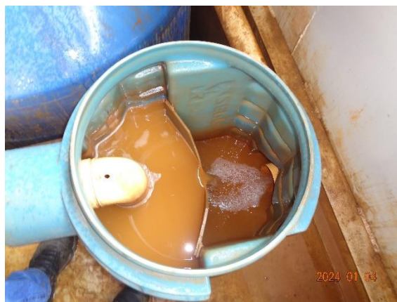
Foto 36 Recipiente com o efluente da CSAO da Oficina, lavadores e ponto de abastecimento.
