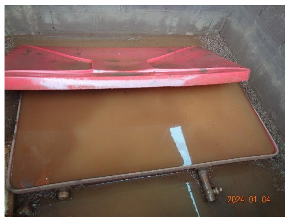
Foto 48 CSAO das Baías de Resíduos e Coleta Seletiva. Transbordo devido a entrada de água de chuva.
