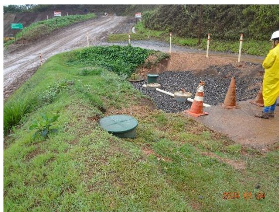
Foto 62 Biodigestor associado aos banheiros da Área Administrativa
