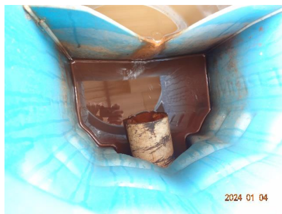
Foto 50 Recipiente que recebe o efluente da CSAO da unidade de Filtro Prensa de Rejeito
