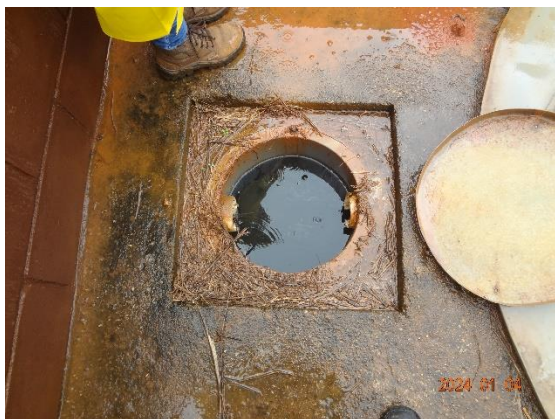
Foto 71 Recipiente de saída do efluente líquido da fossa séptica da UTM a úmido.
