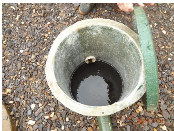
Foto 63 Detalhe da saída de efluente do biodigestor da Área Administrativa.
