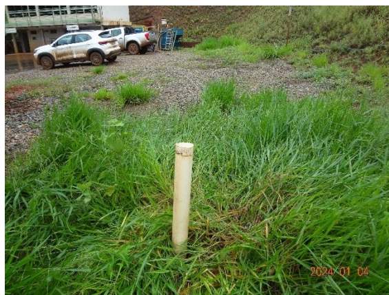
Foto 72 Sistema de sumidouro com cano de acesso para monitoramento do efluente.
