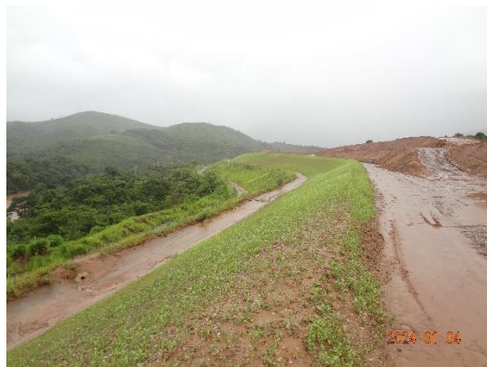
Foto 24 Inclinação do talude e bermas. É possível notar o talude já revegetado.
