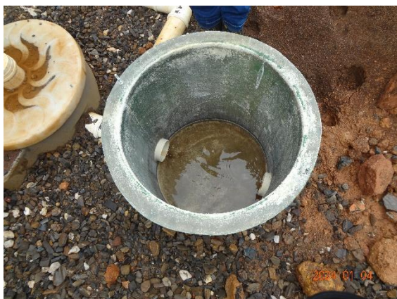
Foto 65 Detalhe da saída de efluente do biodigester da Área de Convivência.
