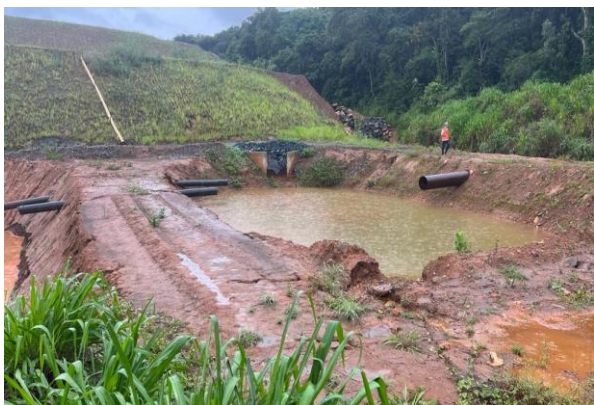
Foto 23 Sumps da pilha definitiva com detalhe ao centro da estrutura de desagüe do dreno de fundo principal.
