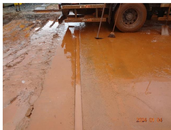
Foto 58 Canaleta na pista de abastecimento com entupimento devido a lama. Sedimento retirado estava sendo conduzido para galpão de armazenamento de sedimentos Classe 1
