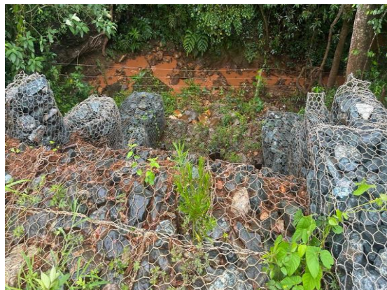
Foto 26 Estrutura de gabião de caixa no vertedouro nos Sumps da Pilha Definitiva de Rejeito.
