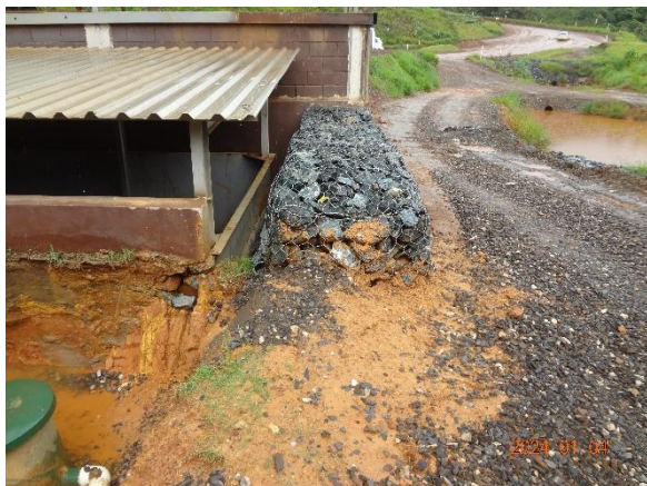
Foto 37 Estrutura em gabião de entrada do sumidouro que recebe o efluente da CSAO da Oficina, lavadores e ponto de abastecimento.
