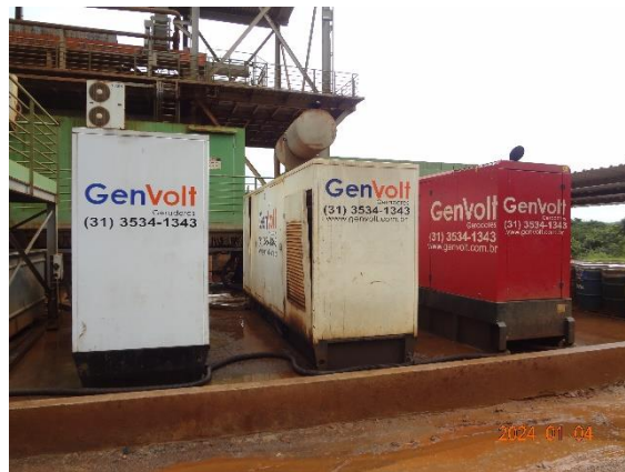
Foto 14 Geradores de energia elétrica da Unidade de Filtro Prensa de Rejeito
