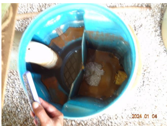
Foto 45 Recipiente que recebe o efluente da CSAO da UTM a Úmido
