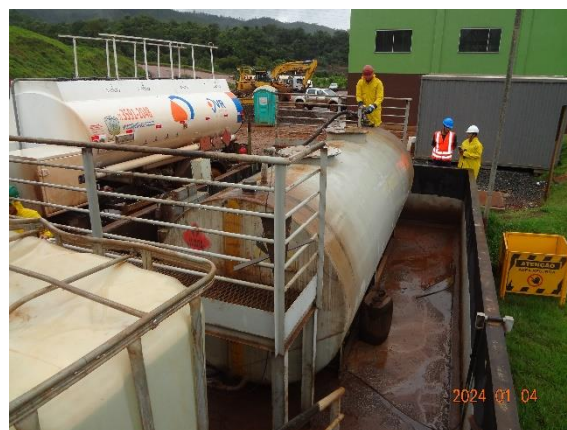
Foto 56 Bacia de contenção do tanque de combustível
