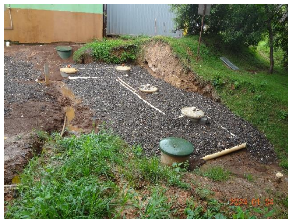
Foto 68 Biodigester associado aos banheiros da balança de saída de produto do empreendimento
