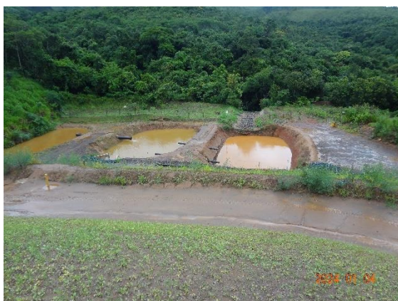
Foto 21 Sumps principais que captam toda a água que verte da pilha definitiva de rejeito.
