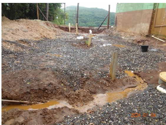
Foto 69 Sistema de sumidouro associado ao biodigester da balança de saída de produto do empreendimento.
