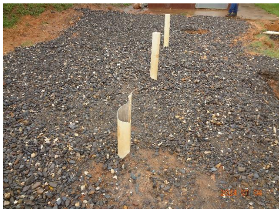
Foto 67 Sistema de sumidouro associado ao biodigester da oficina mecânica
