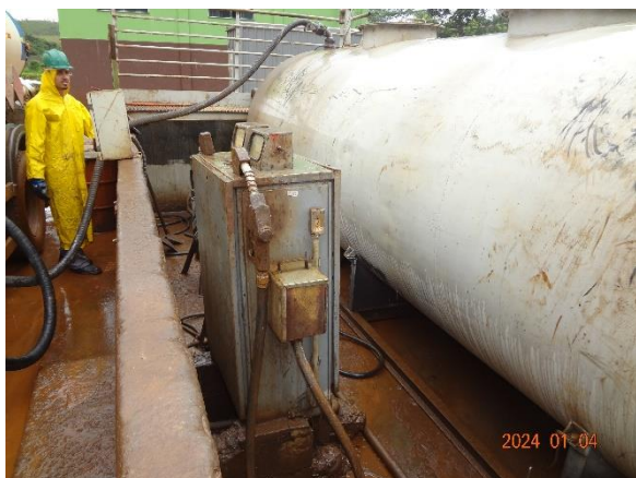
Foto 57 Bomba de combustível localizada dentro da bacia de contenção do tanque
