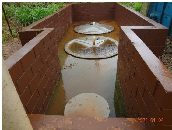
Foto 70 Fossa séptica associada aos banheiros e escritórios na UTM a Úmido.
