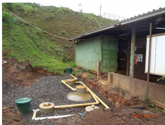
Foto 64 Biodigestor associado ao banheiro da Área de Convivência
