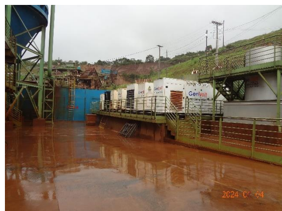
Foto 6 Geradores que sustentam a UTM e todas as estruturas associadas.
