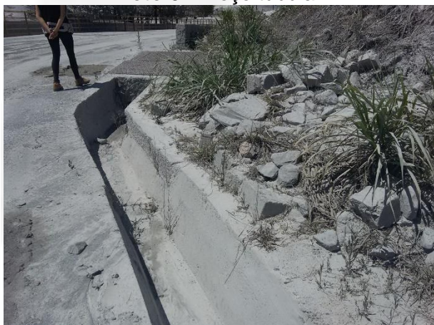
Foto 03. Canaleta e caixa de decantação de água pluvial.
