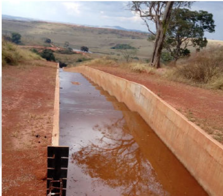
Extravasor da barragem de rejeitos.
