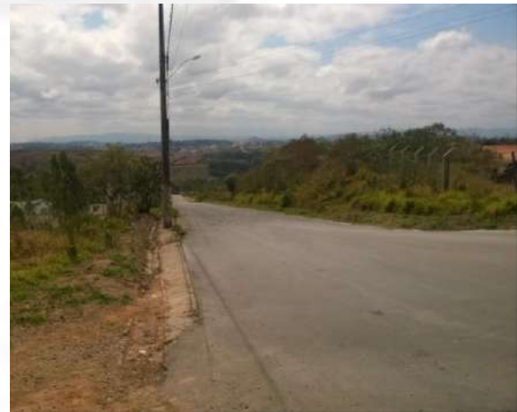
Foto 02. Uma das vias com pavimento asfáltico
