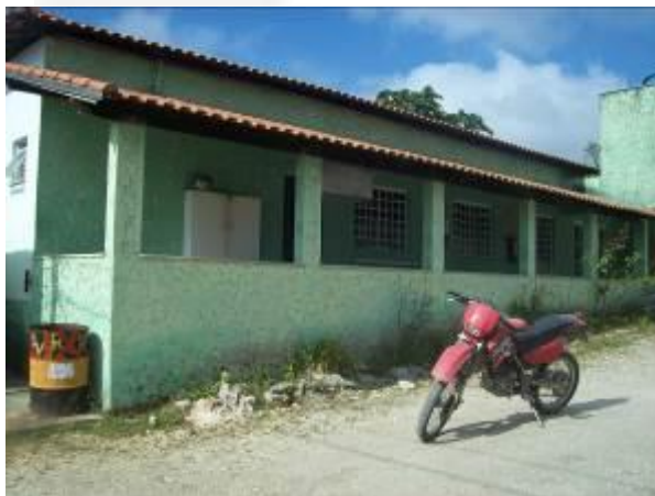
Foto 01. Vista do refeitório.
