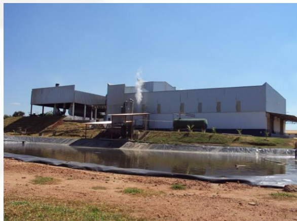
- Sistema de tratamento efluente
