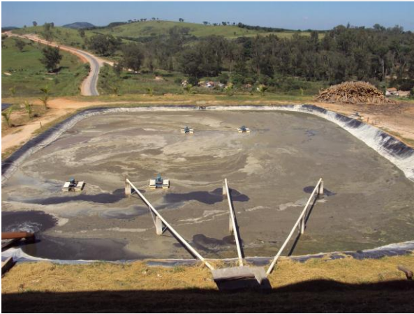
- Lagoa de tratamento anaeróbia
