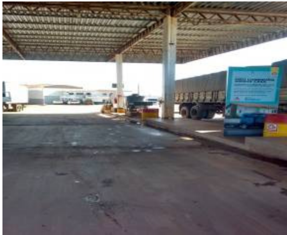
Foto 01. Pista de abastecimento
