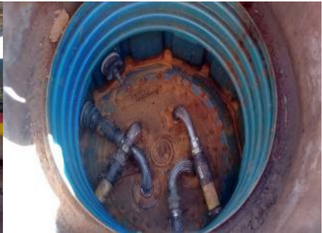
Foto 02. Sump da boca de visita do tanque
