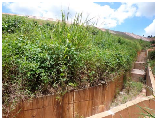
Foto 02. Sistema de Drenagem Periférica.
